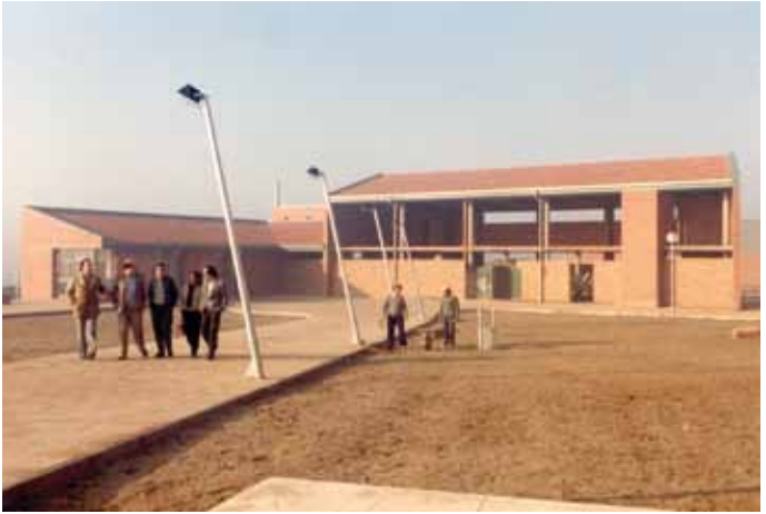
Construcció del centre cívic Can Bassa, anys 80. Autor: Joan Mas / Fons Ajuntament de Granollers / AMGr
