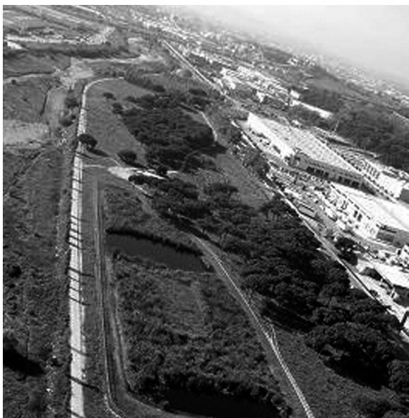
Foto aèria del riu Congost i l'aiguamoll construït de Can Cabanyes
