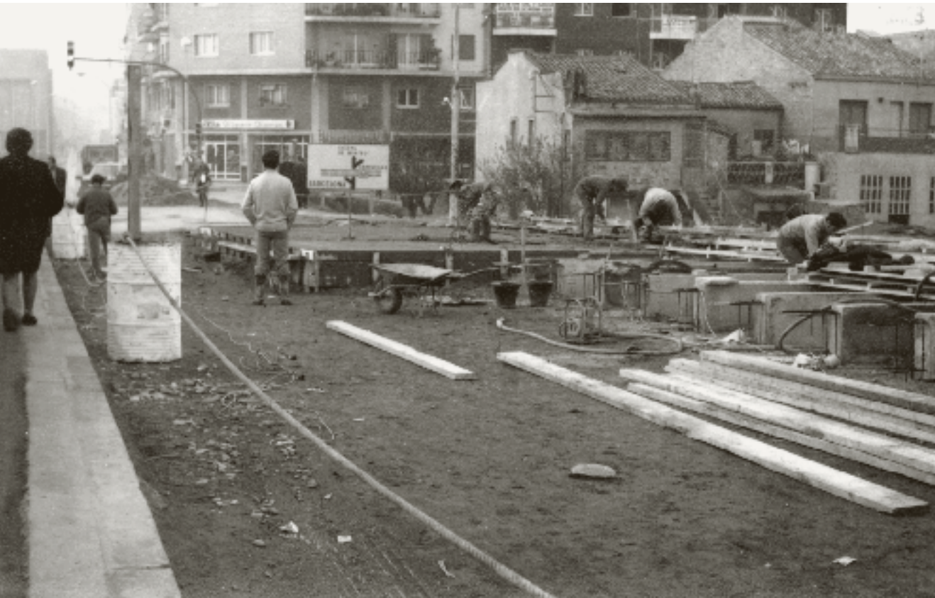
Obres de rehabilitació al pont de la carretera de Caldes per millorar l'accés al barri. Foto: Arxiu AV Barri Congost
