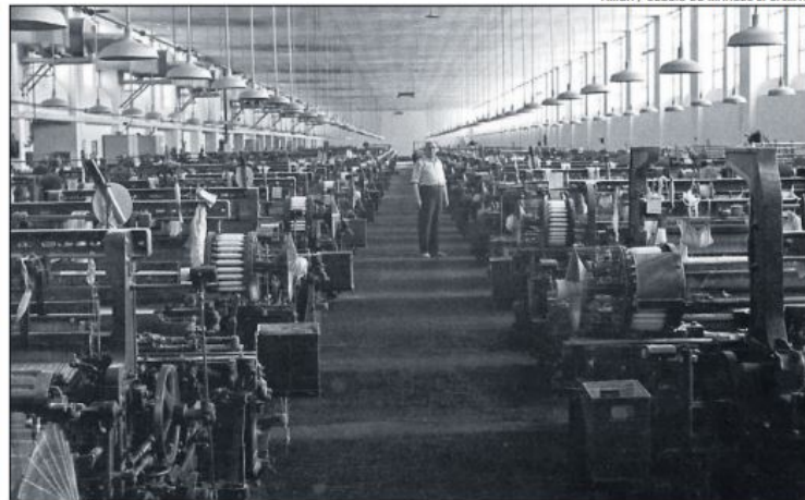
LA MAQUINÀRIA Vista de la nau als anys 60 amb el cap de secció al mig dels telers, anomenats 'de revòlver'
