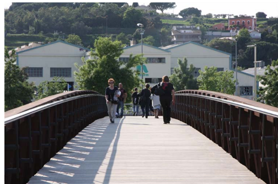
Pas sobre el riu Congost en direcció a la nova actuació
