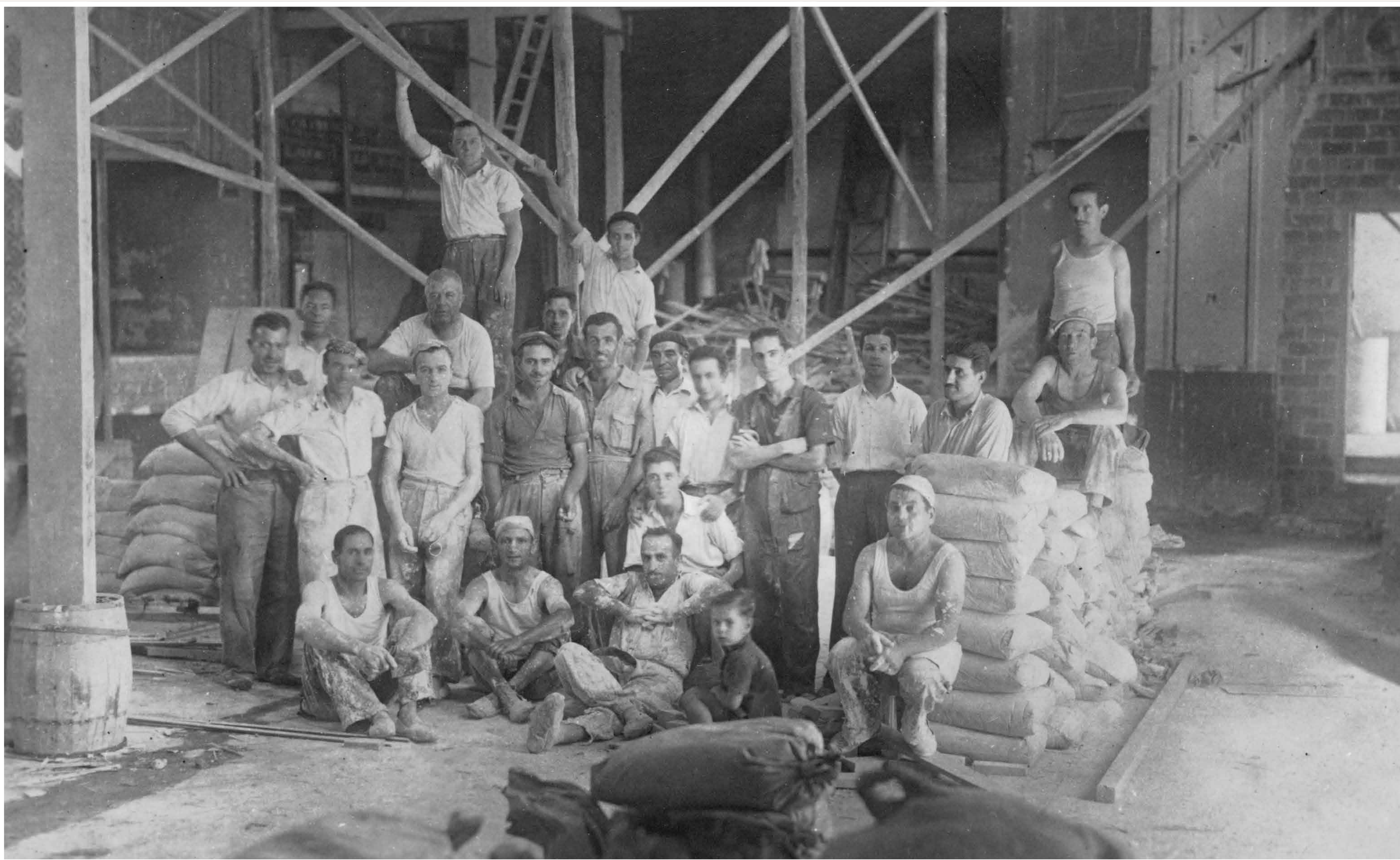
UNA BRIGADA DE PALETES, 1945 Obres de remodelació a l'interior del cinema Majèstic, aleshores anomenat Coliseum. Retrat dels treballadors enmig de les bastides i dels sacs de ciment. Fotografia i Fons Joan Guàrdia
