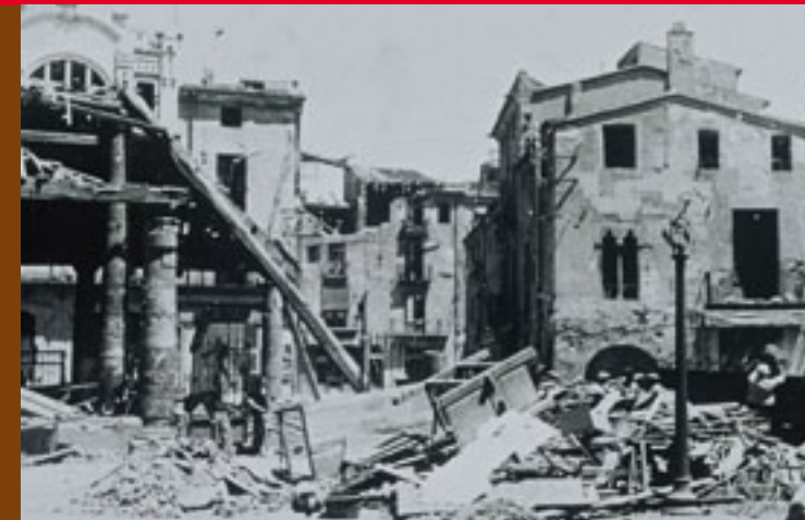
Treballs de desenrunament als edificis afectats pel bombardeig de la Porxada i al seu entorn. BNE. Madrid
