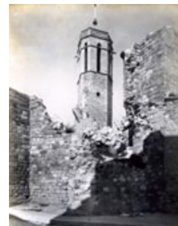
Restes de l'enderroc de l'església gòtica de Sant Esteve, l'any 1937. SPAL. Diputació de Barcelona.
