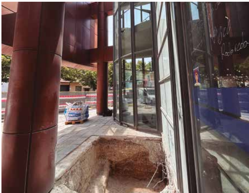
Obres a la façana del Teatre Auditori de Granollers per instal·lar el nou ascensor
