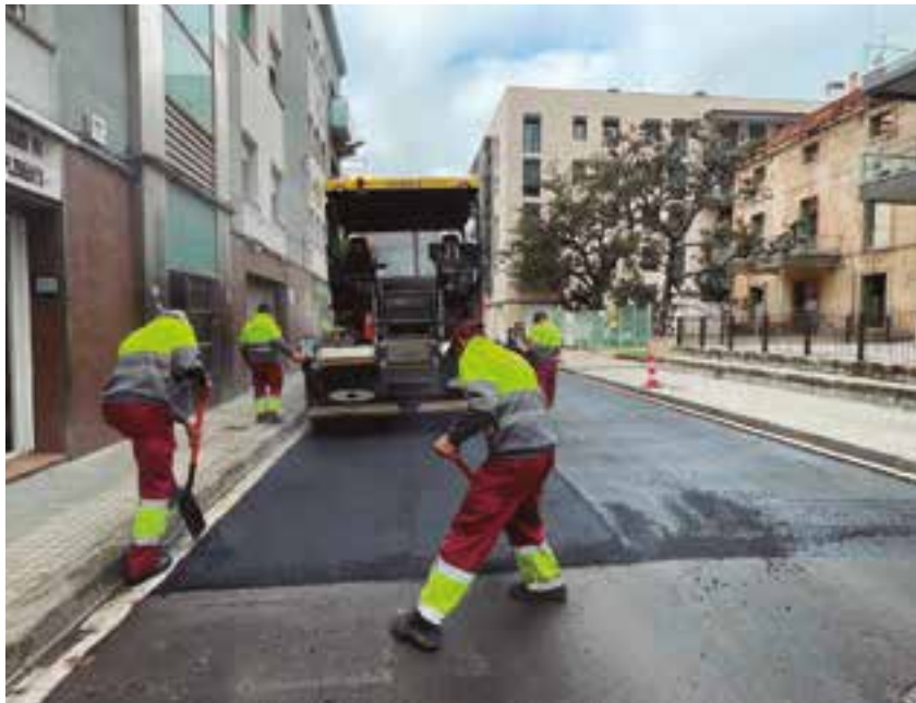
Treballs d'asfaltatge i de millora de l'accessibilitat al carrer de Martí Grivé i a diversos carrers de l'entorn de l'avinguda Sant Esteve durant el mes de gener
