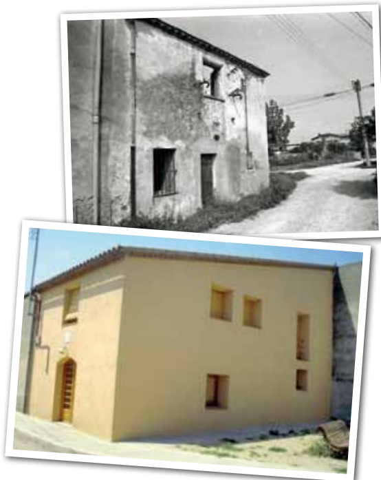
A DALT, L'ANTIC AJUNTAMENT DE PALOU ABANS DE LA REHABILITACIÓ DE L'EDIFICI QUE ES VA CONVERTIR EN CENTRE CÍVIC. FOTO: JOSEP NOGUÉS. A SOTA, DESPRÉS DE LA REHABILITACIÓ (1986). AUTOR I FONTS: PERE CORNELLAS/ARXIU MUNICIPAL DE GRANOLLERS
